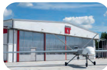
Завод Кронштадт, г. Москва
