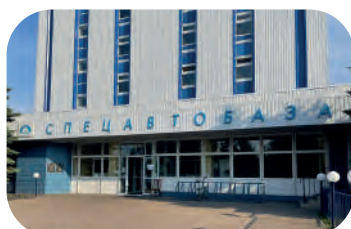
ГУП Водоканал, г. Санкт-Петербург
